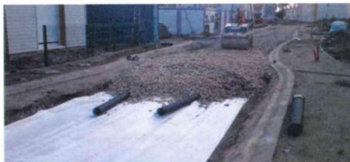
Le volume de stockage correspondra à la couche d'assise de la voirie, constituée d'un matériau filtrant qui devait être exempt de fines et généralement constitué de pierres ou galets ou Grave non traitée 20/80 1 (porosité 30 %) prévu sur une épaisseur de 100 cm le tout recouvert par la structure de la circulation des parking et voies de circulation VL et PL (lié à l'activité du site de la déchèterie).
